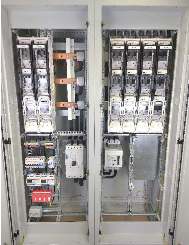
Schaltanlage ausgelegt zum Anschluss einer 330 kWp Photovoltaikanlage incl. Netz- und Anlagenschutz nach VDE-AR-N 4110, welche bei einem Unternehmen aus dem Bereich Abfallbeseitigung und Städtereinigung zum Einsatz kommt.
