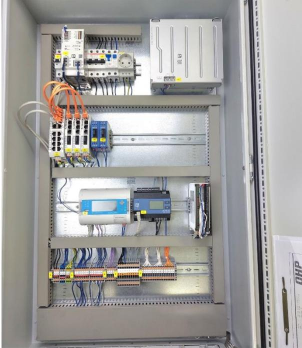
Fernwirkanlage ausgelegt zum Anschluss einer 1.016 kWp PV-Anlage nach VDE-AR-N 4110, welche bei einem Logistik-Unternehmen zum Einsatz kommt.
