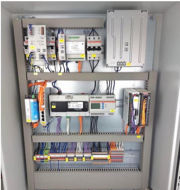
Fernwirkanlage ausgelegt zum Anschluss einer 225 kWp Photovoltaikanlage nach VDE-AR-N 4110, welche bei einem Bäckereunternehmen zum Einsatz kommt.
