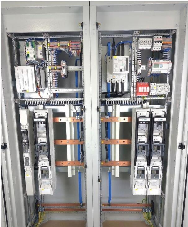
Schaltanlage ausgelegt zum Anschluss einer 187 kWp Photovoltaikanlage incl. Netz- und Anlagenschutz, welche bei einem Unternehmen aus dem Bereich Werkzeugbau und Kunststoffproduktion zum Einsatz kommt.
